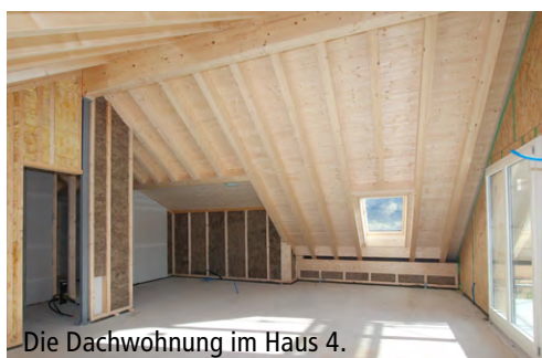
Der Bau schreitet zügig voran.
