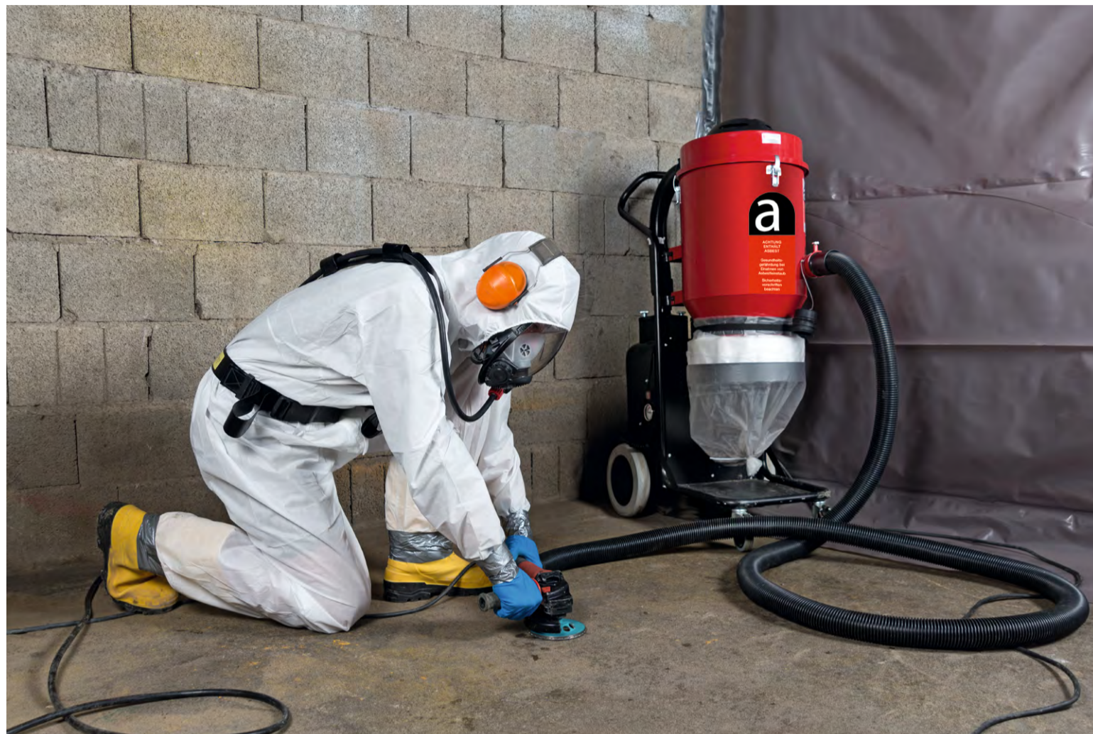
Einer unserer Asbest-Spezialisten bei der Arbeit.
