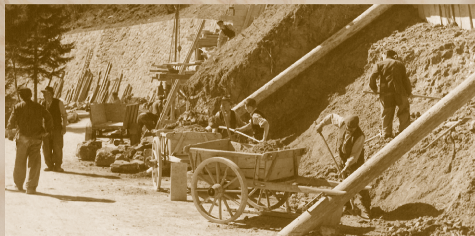
Hangsicherungsarbeiten an der Strasse Frutigen-Adelboden um 1954.
