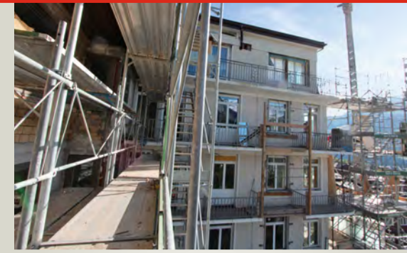
Das Bellevue im Umbau.
