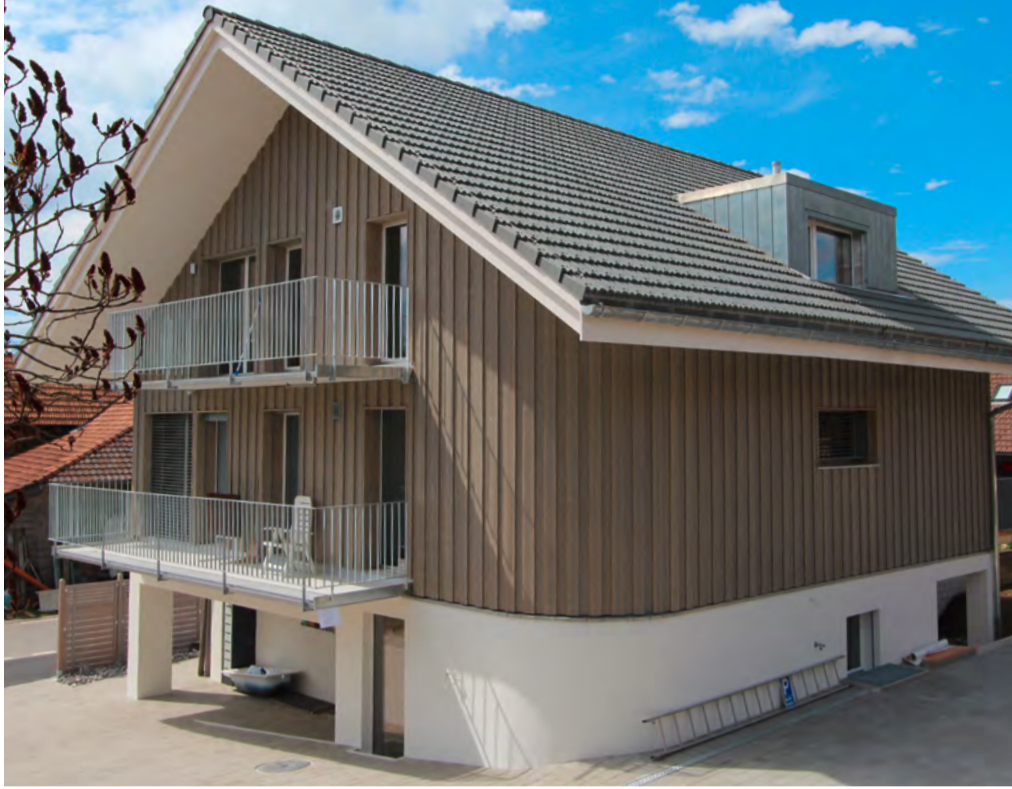
In diesem modernen Elementbau sind die neuen Alterswohnungen entstanden.
