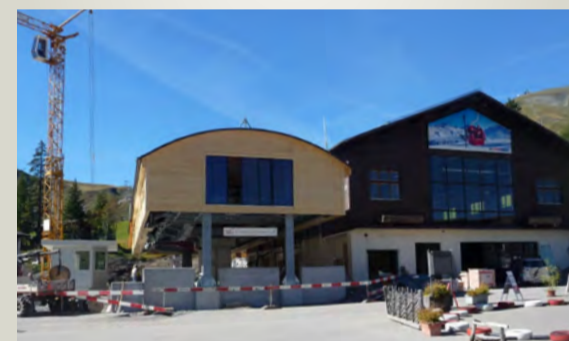
Die neue Talstation steht direkt neben der alten Station.
