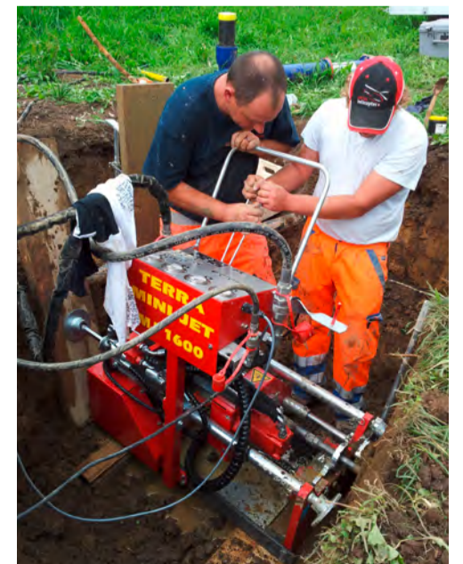
Unsere Mitarbeiter beim Platzieren der Kompaktbohranlage.
