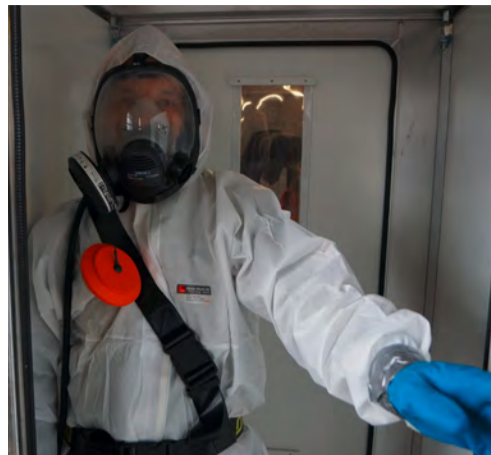
Ein Asbestspezialist in Vollmontur.
