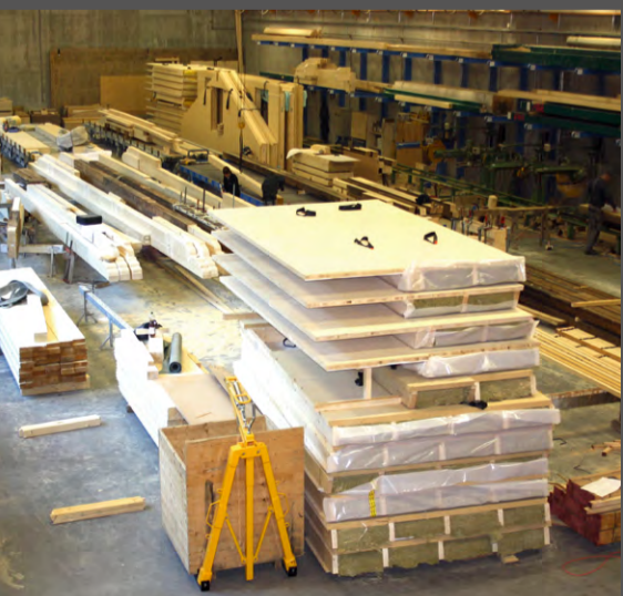
In der neuen Abundhalle wurden in den vergangenen Monaten acht Häuser abgebunden.
