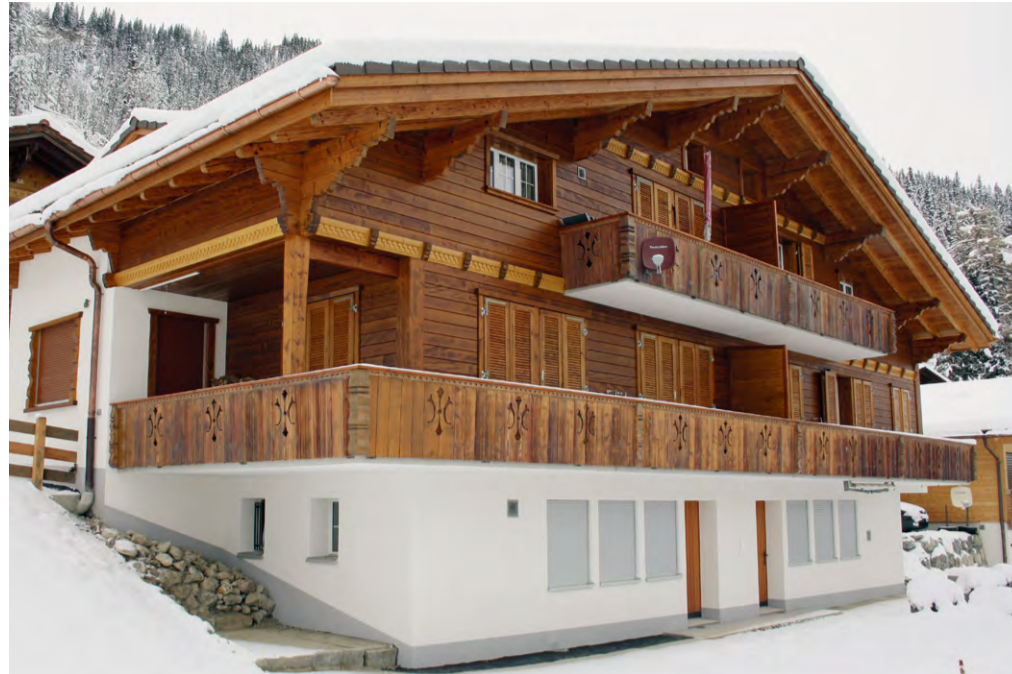
Gesamterneuerung Chalet Bonderblick: Fenster, Fassade und Dach wurden komplett saniert.
