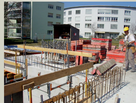
Der Neubau wächst. Bereits ist die Decke über dem Untergeschoss betoniert.
