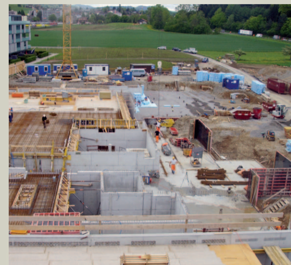
Grossbaustelle an der Worbstrasse 316 in Gümligen.
