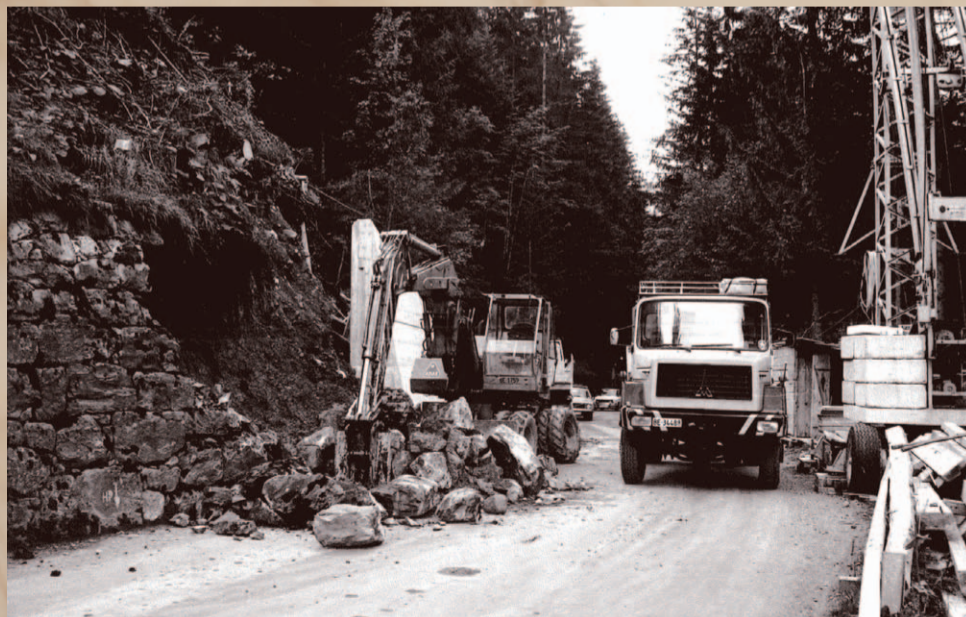
Ausbau Strasse Frutigen-Adelboden: Neben dem Bagger der Deuz-Lastwagen von 1964.
