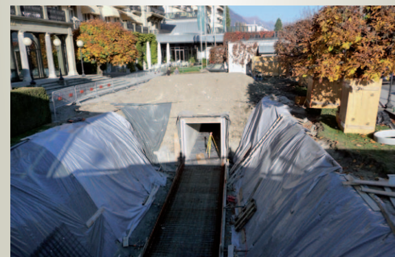
Aus Sicherheitsgründen wurden die beiden Bucherer-Filialen unterirdisch verbunden.
