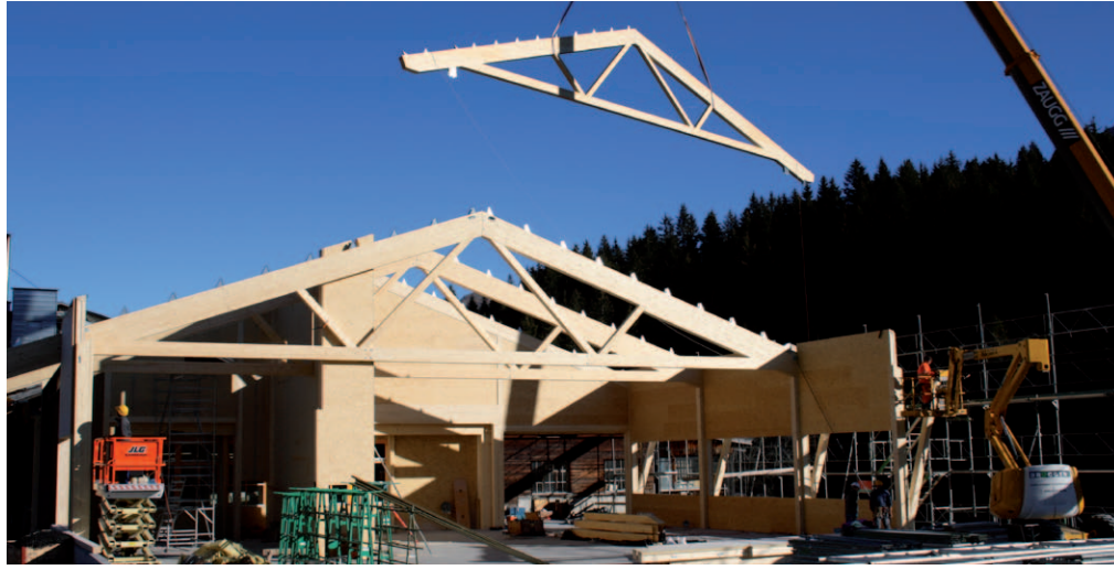
Dank Wetterglück und guter Vorbereitung konnte die Halle vor dem Winter aufgerichtet und gedeckt werden.
