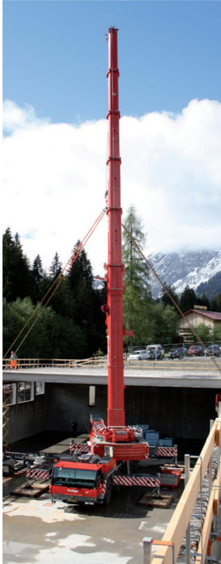
22 Rippen-elemente à 26 Tonnen wurden mittels Pneukran montiert.
