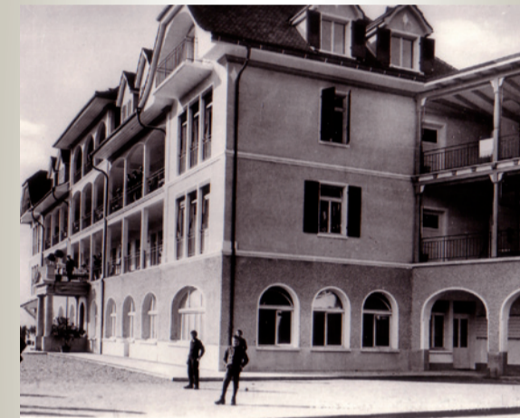
Das Kurhaus wird einer kompletten Sanierung unterzogen.
