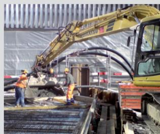
Die Decke des neuen Verbindungsganges wird betoniert.
