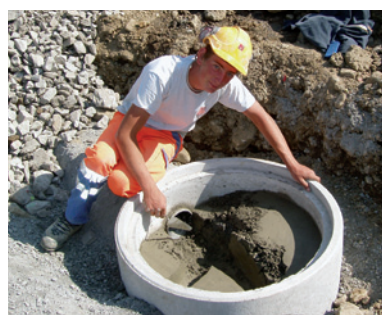
Oliver Bärtschi, 2. Lehrjahr, beim Fertigen eines Schachtbanketts.
