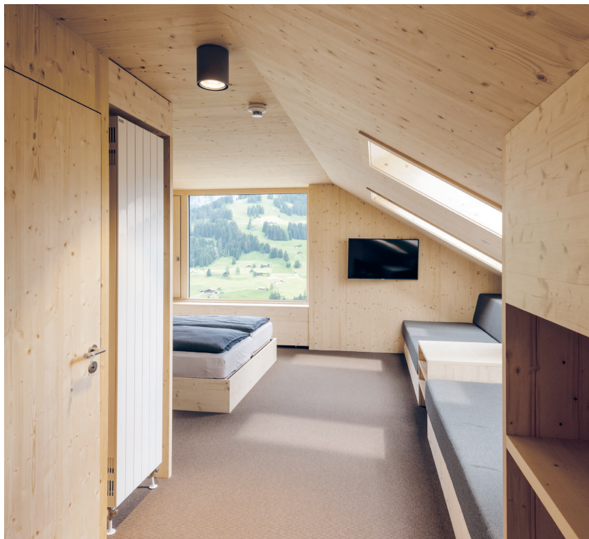
Kein Schnickschnack: Wände aus Blockholzplatten mit UV-Schutz-Beschichtung behandelt, Teppich am Boden. Speziell ist der schmale Lüftungsflügel neben dem Fenster.
